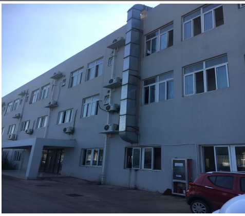
食堂油烟处理设施
