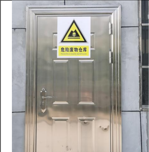
危废库建设情况
