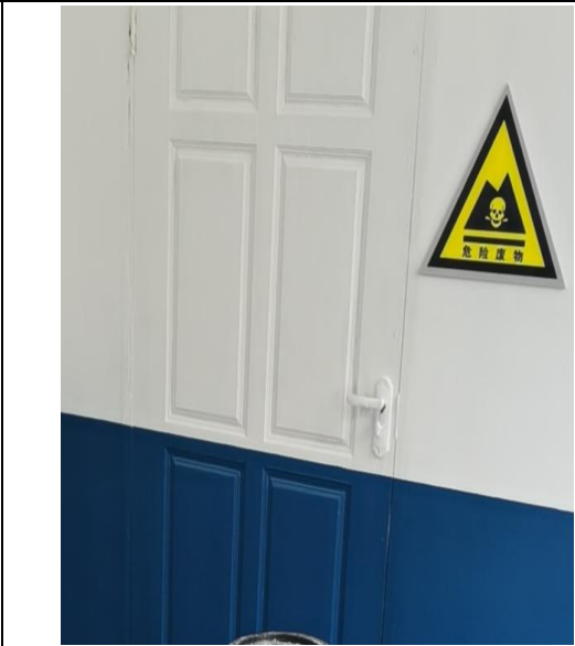
危废库建设情况
