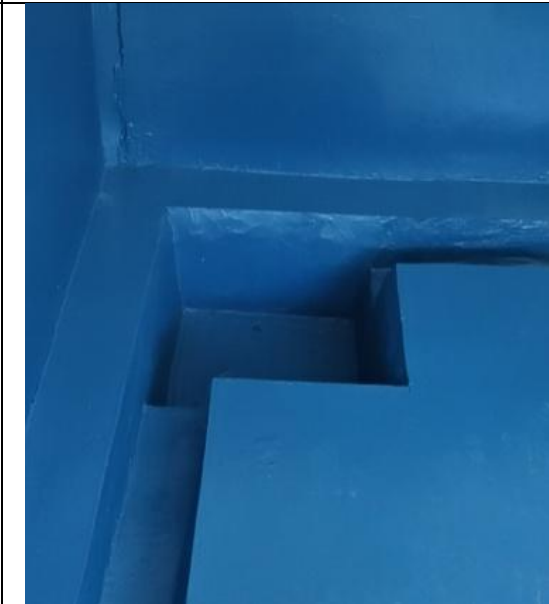
危废库建设情况
