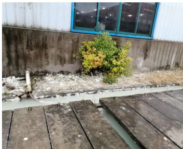
循环水沉淀池
