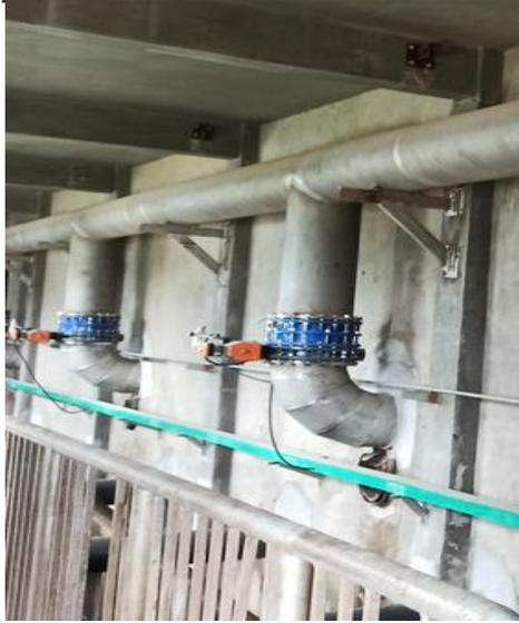
10、污泥回流泵房：由于污泥泵房顶板比沉淀池低，造成停电后，沉淀池水位高于污泥泵房顶板，发生溢流。需考虑将泵房污泥管出口闸门改为速闭闸，避免发生停电等事故时，发生污泥泵房事故漫流；同时，污泥回流泵及配电柜腐蚀严重。
