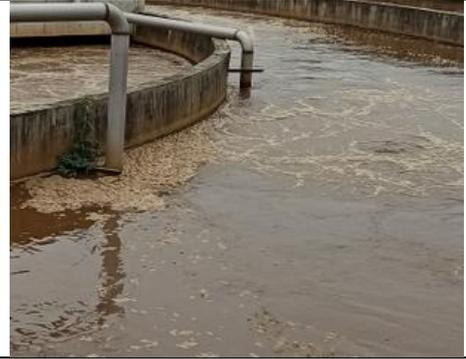
9、絮凝池、V型滤池目前未运行，因为无法正常工作，过滤周期过短；滤池管廊内，电动阀门损坏较多，管道腐蚀严重。
