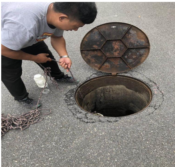
废水总排口 W1
