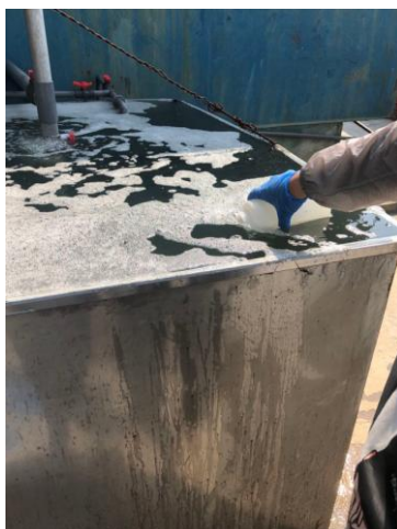
污水处理站进口
