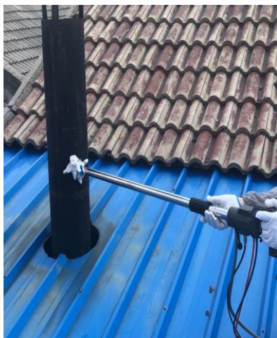
燃气锅炉废气出口
