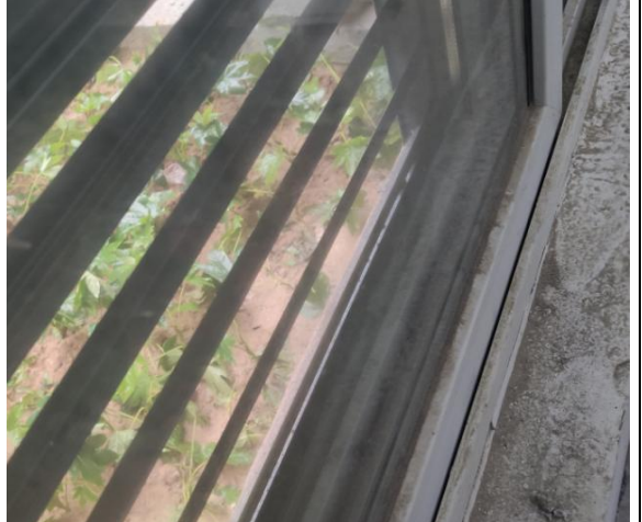
配电房双层玻璃隔声门窗
