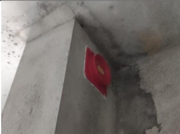
住宅厨房预设油烟排放管道
