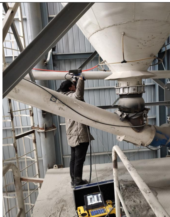
2#生产线粉料仓排气筒出口废气测点
