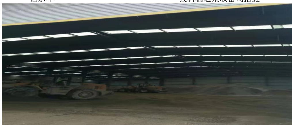
原料堆场密闭并安装洒水喷淋设施
