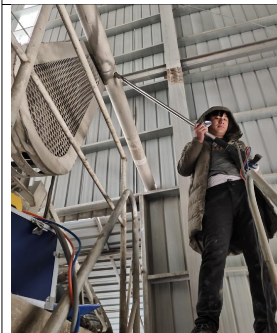
1#生产线搅拌机排气筒出口废气测点
