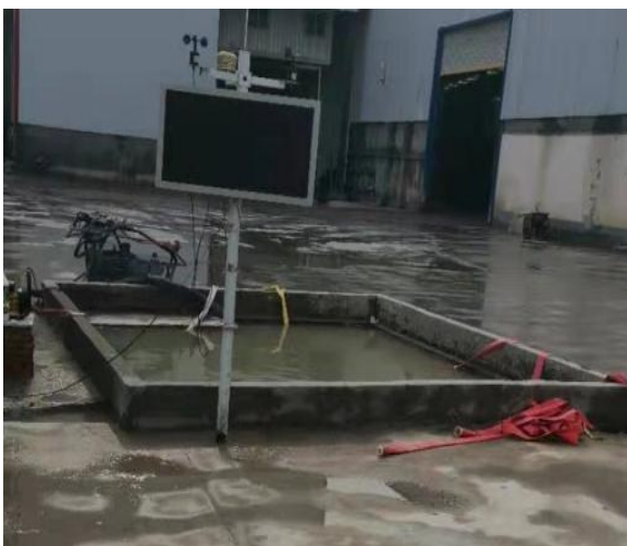
车辆冲洗废水沉淀池
