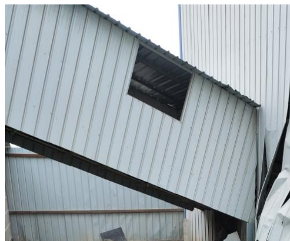
投料输送采取密闭措施
