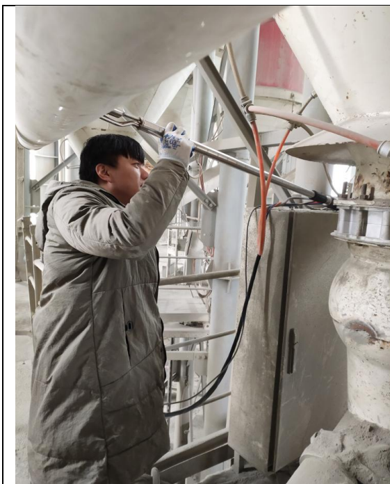
1#生产线粉料仓排气筒出口废气测点
